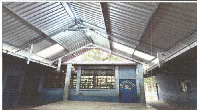
Foto 2: Culminacion de trabajos de instalacion de costaneras, laminas troqueladas y tendido electrico en el espacio correspondiente al escenario.
