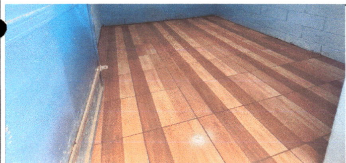
Foto 5: Colocacion de piso ceramico en espacio de direccion, el cual se cambio por piso rustico en una medidad de 12 metros cuadrados.
