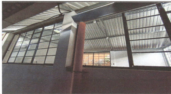
Foto1: Finalizacion en el cernido de paredes, en todas las areas del espacio previsto para cocina, e instalacion de ventanas.
