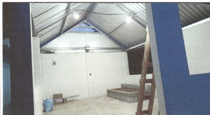
Foto 3: Culminacion de trabajo de cernido en paredes, instalacion de ventas y tendido electrico.
